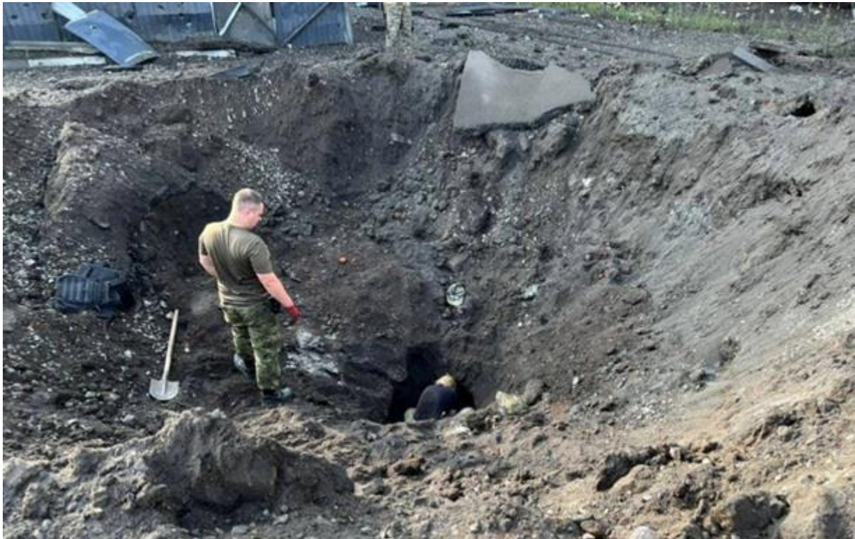
Рисунок 2 – Вид на асфальтобетонне покриття в місці прильоту ракети С-300
