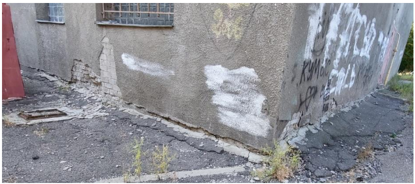
Рис. 1. Північно-східний кут будівлі
