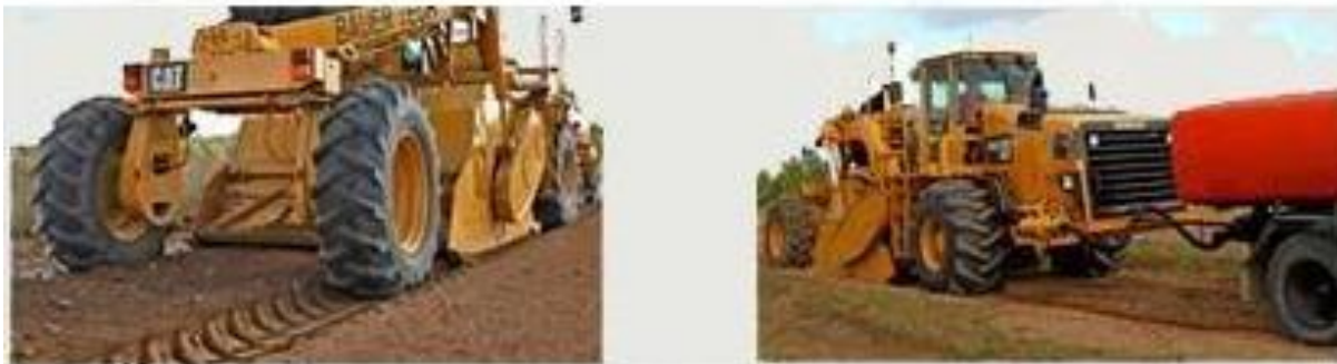
Рисунок 1 – Введення в'язучого у ґрунт за допомогою ресайклера
