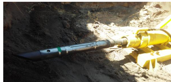
Рис. 2. Процес проколювання ґрунту експериментальною установкою з можливістю керування траєкторією руху головки в підземному просторі
