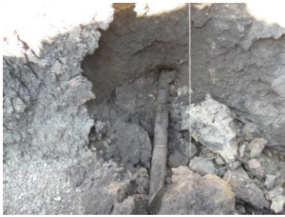
Рис. 3. Заміри відхилення руху головки з асиметричним наконечником на виході в приймальному котловані
