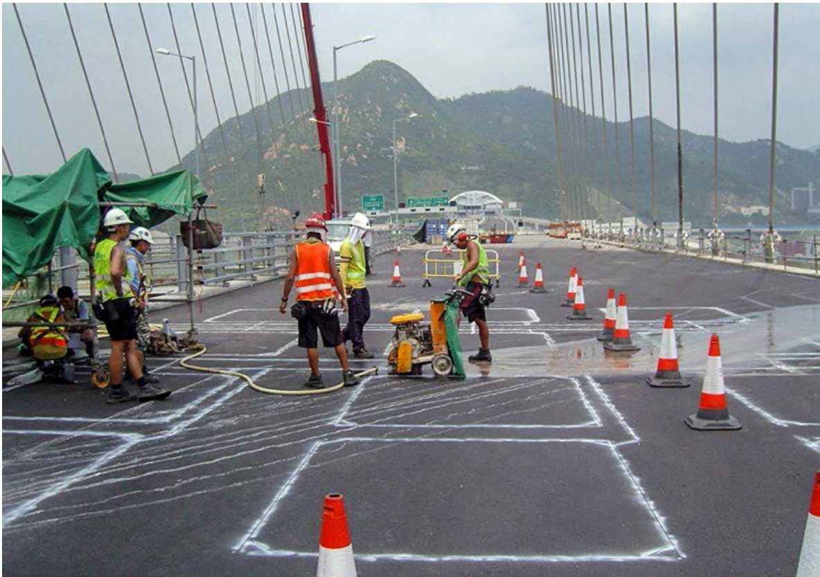
Рисунок 2 - Приклад системи WIM, встановленої на мосту в Китаї
