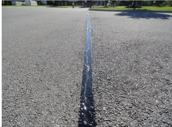
Рисунок 5 – Ділянка відремонтованої дороги
