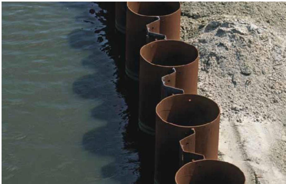
Рисунок 2 – Варіант комбінованої шпунтової стінки
