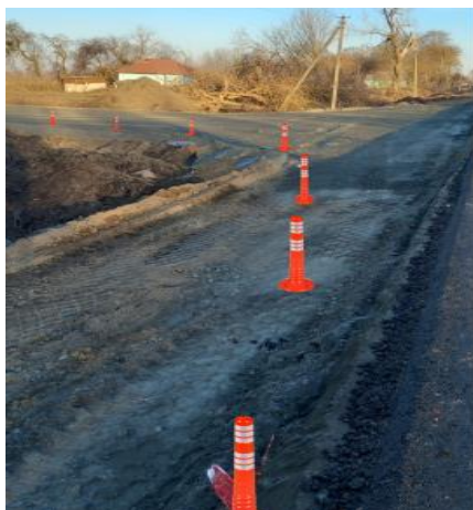
Рис. 3 – Розбивка з'їзду під шар СФОВ М-20
