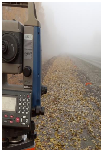
Рис. 1 – Контроль встановлення струни електронним тахеометром
