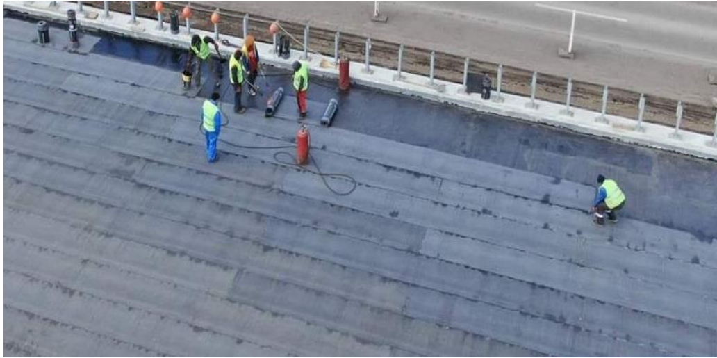
Рисунок 3 – Рулонно-мастична гідроізоляція
