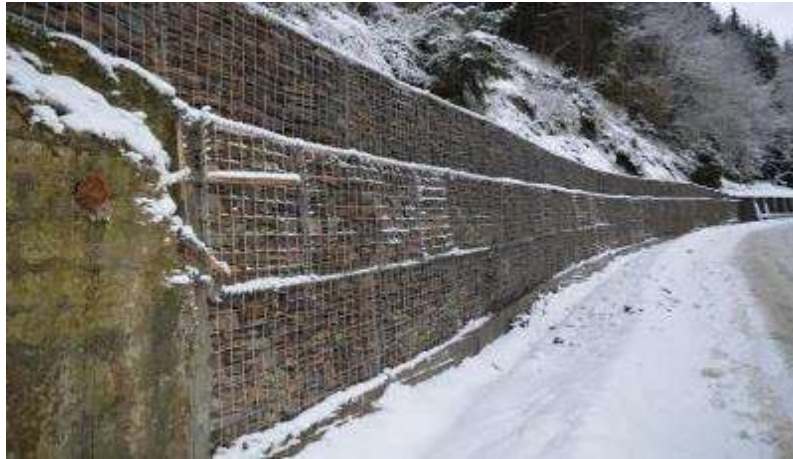
Рисунок 4 – Ділянка автодороги Міжгір'я – Колочава на Синевирському перевалі: габіонові конструкції
