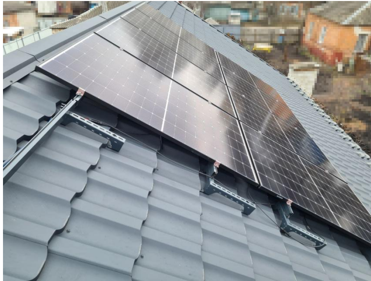
Рисунок 2 – Монтаж на скатний дах
