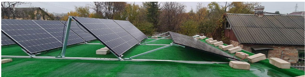
Рисунок 3 – Монтаж на плоский дах
