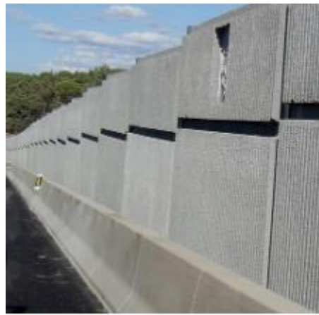
Рис. 1. Бетонний шумозахисний екран
