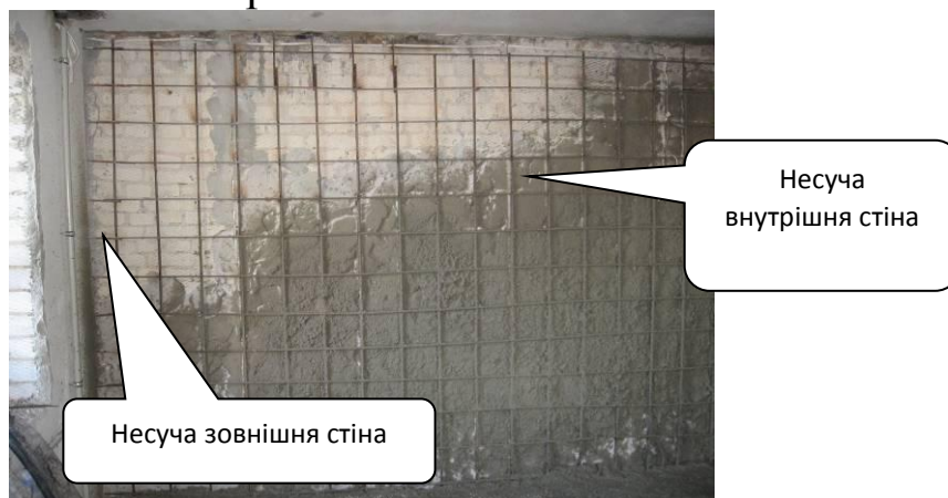
Рис. 1. Підсилення стін за рахунок додаткового армування [1]
