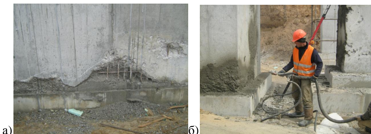
Рис. 6. Технологія виконання робіт: а – фрагмент несучої колони будівлі 1-го терміналу аеропорту; б – виконання робіт з підсилення колон [4]
