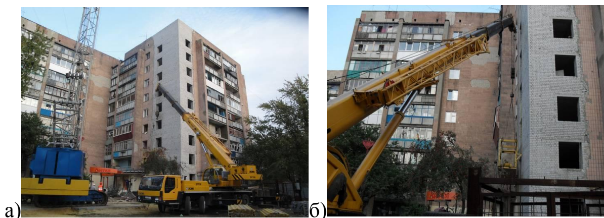
Рис. 2. Технологічна схема виконання робіт: а – використання двопоршневого розчинобетонасосу; б – розчинобетонасос на підвісному майданчику [1]
