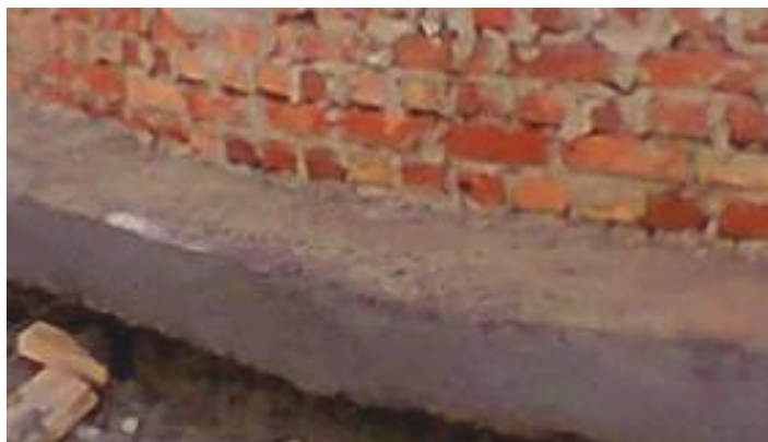
Рис. 5. Основа купола після підсилення [1]
